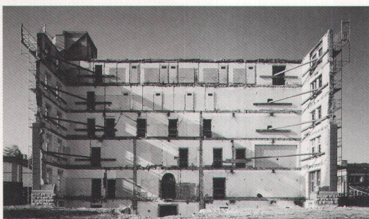
Seitenwände und die strassenseitige Hälfte des Gebäudes blieben stehen ...
