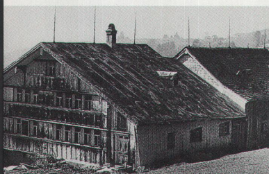
Das Tätschdach-Bauernhaus von 1519
