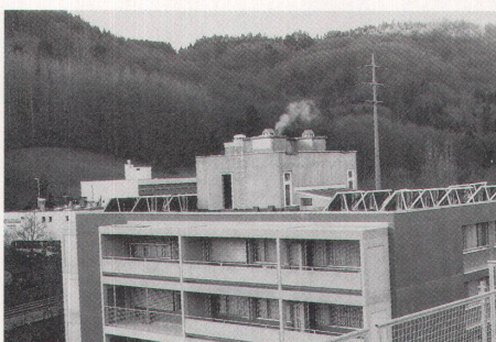
Solaranlage zur Warmwasservorwärmung
