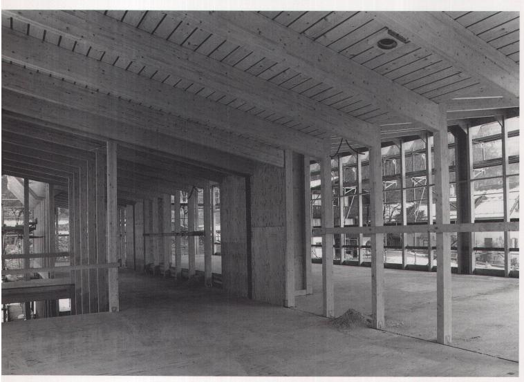
Primär- und Sekundärbalken bilden einen Raster im Mass von 120 cm durch das gesamte Gebäude
