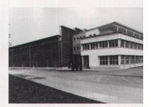
Die Dreiteiligkeit des Gebäudes ist sichtbar. Links die Lagerhalle aus Holz, dazwischen der Betonbau und schliesslich die Holzkonstruktion des Bürohauses. Vor dem eingang die Kunst am Bau von Josef Maria Odermatt
