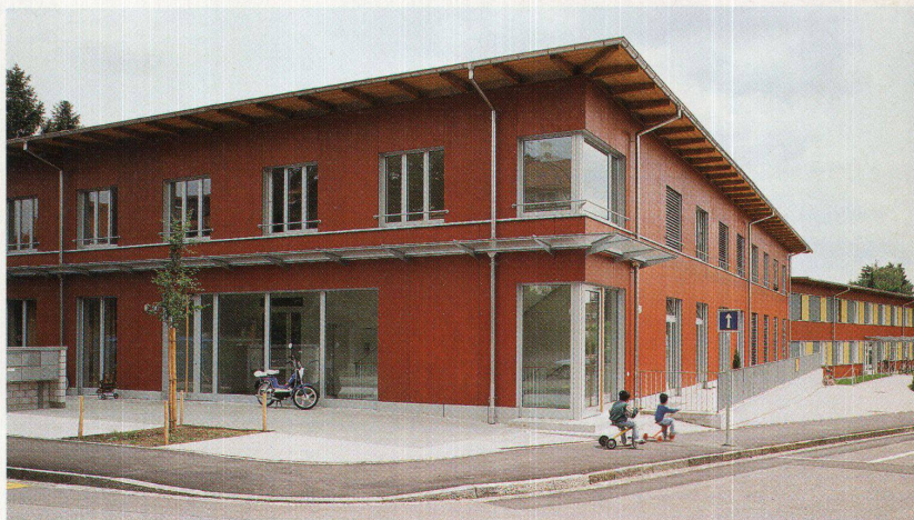
Der Kopfbau mit dem erhöhten Erdgeschoss enthält die beiden Gemeinschaftsräume und Kleinwohnungen
