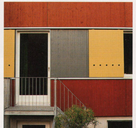
Gartenaustritt aus dem Schaltzimmer
