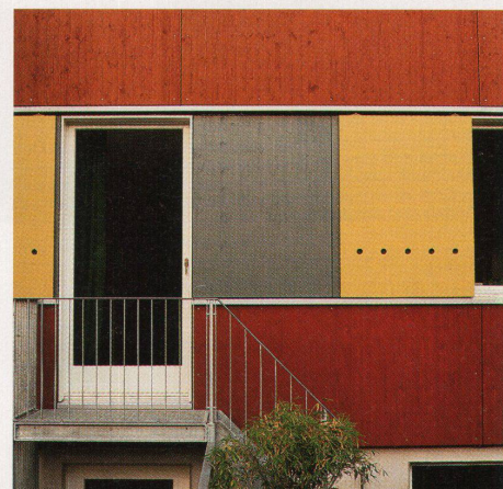
Gartenaustritt aus dem Schaltzimmer
