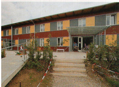
Die Fassaden gegen die Strasse. Die Vordächer verdeutlichen die Hauseingänge
