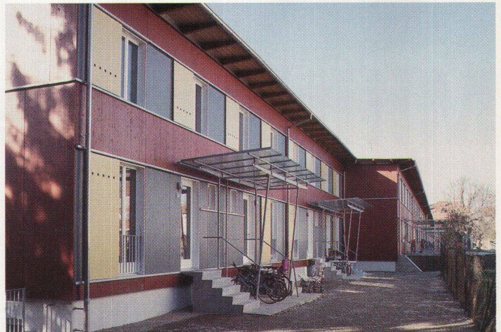
Siedlung Niederholzboden der Metron. Der Raumluft wird die Abwärme entzogen
