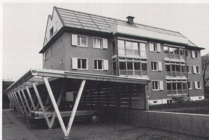
Das erste Solar-Mehrfamilienhaus der Schweiz steht in Sevelen SG. Architekten Altherr + Traber, St. Gallen
