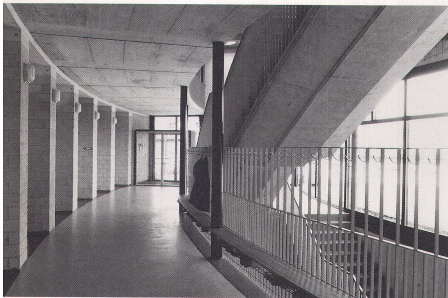
Blick in die Eingangshalle des Schultrakts
