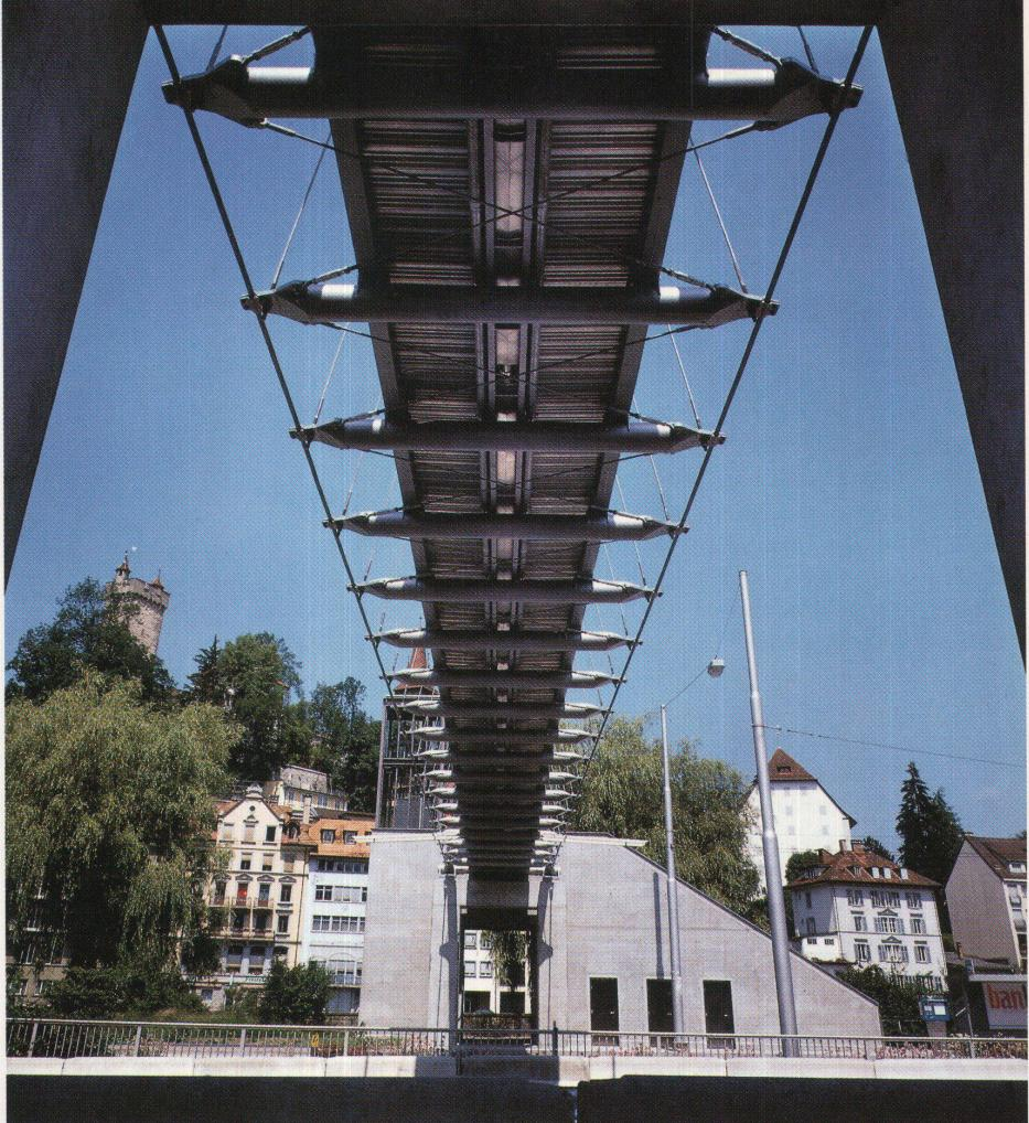
rene Autobahn durfte nur kurz unterbrochen werden. Darum wurde eine Konstruktion gewählt, die auf einem benachbarten Parkplatz fertig montiert werden konnte. Mit zwei Pneukrane wurde die 35,5 Tonnen schwere Brücke in wenigen Stunden nachts an ihren Platz gehievt. Die Leichtbauweise ist also eine Antwort auf die Bedingungen des Ortes.
