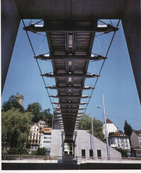
Untersicht der Brücke. Spiralseile der Bogenaussteifung, Hängekabel, Quer- und Längsträger, Beplankung zeigen die Klarheit des Kräftespiels
