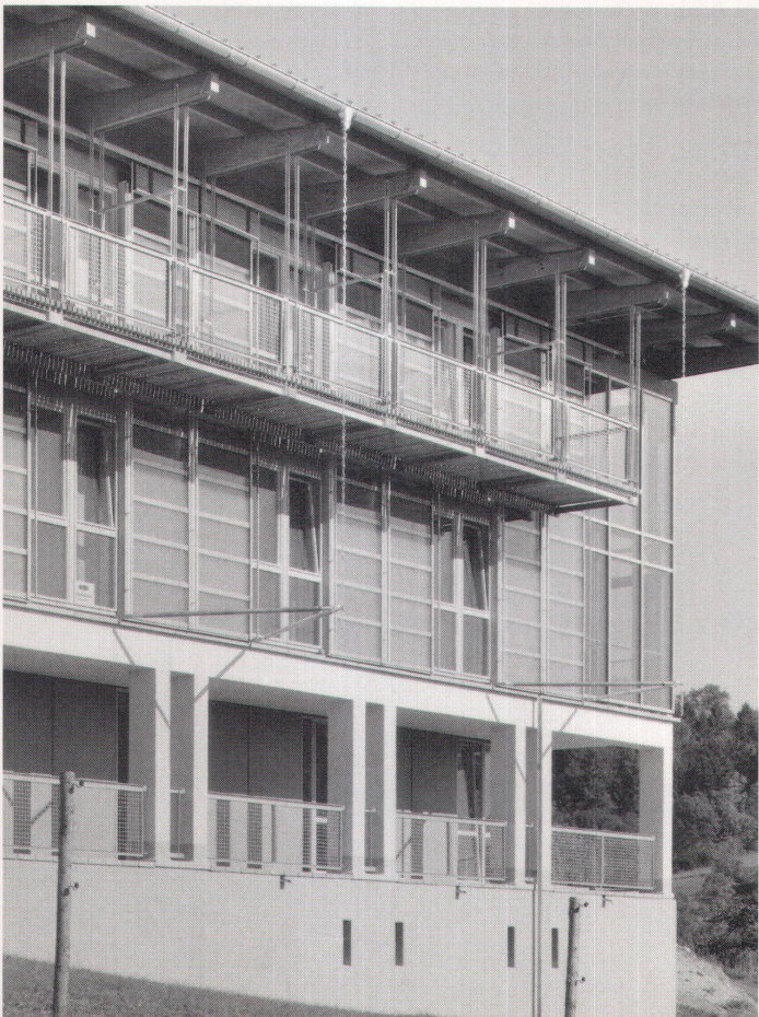
Die sonnseitige Fassade: Mit den Fenstern wechseln die Paneelen für die transparente Wärmedämmung ab
