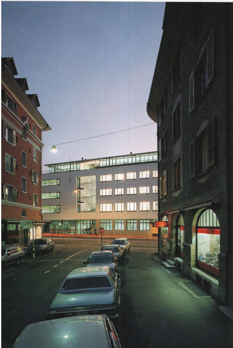
Blick aus dem Seidenweg auf die inszenierte Baunaht
