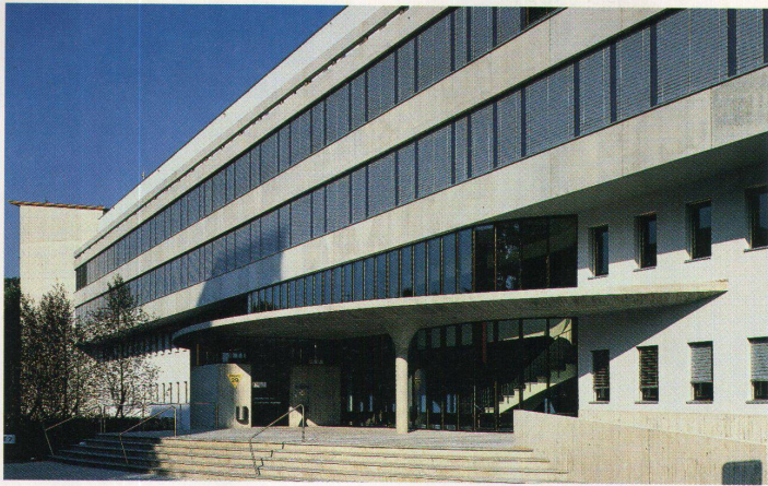
Südostfassade mit dem Eingangsbereich
