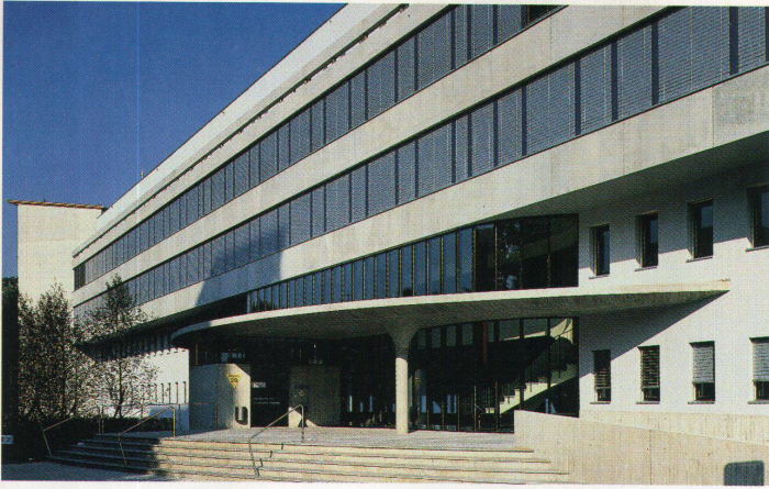
Südostfassade mit dem Eingangsbereich
