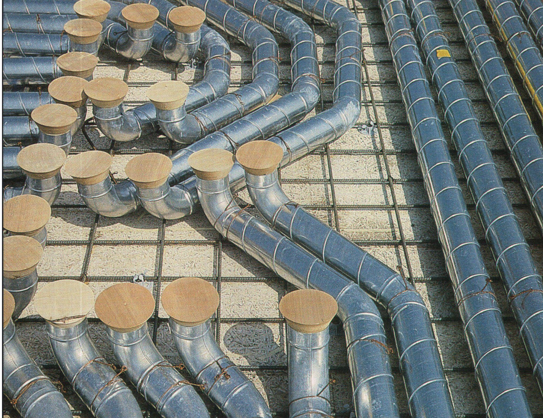
Über ein Rohrsystem strömt Warmluft ins Gebäudeinnere, in Böden und Wände
