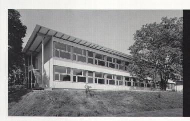
Die Fassade der Südseite wurde mit gelbgestrichenen Duripanelplatten verkleidet
