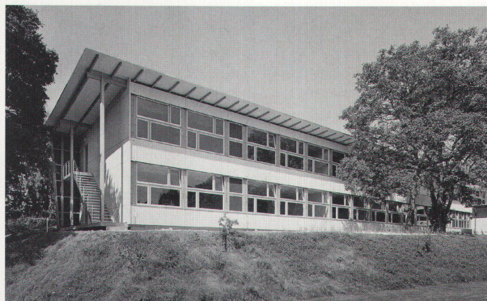
Die Fassade der Südseite wurde mit gelbgestrichenen Duripanelplatten verkleidet
