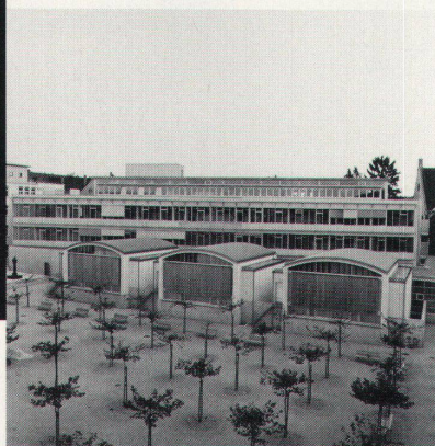
Anbau Lerchenweg mit den davorliegenden Hörsälen
