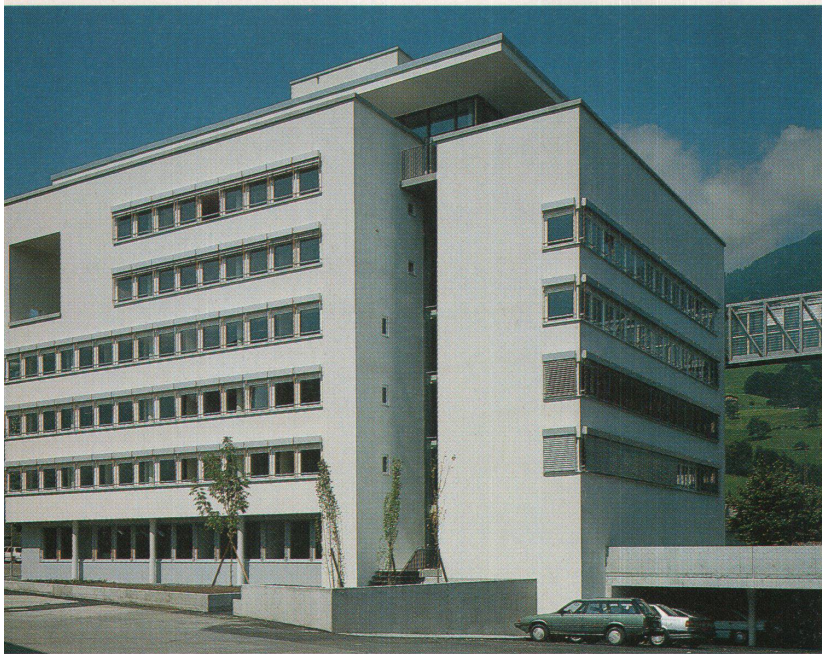
Das Gebäude von Süden. Hinter dem grossen Ausschnitt liegt die Loggia der Hauswartwohnung (links)
