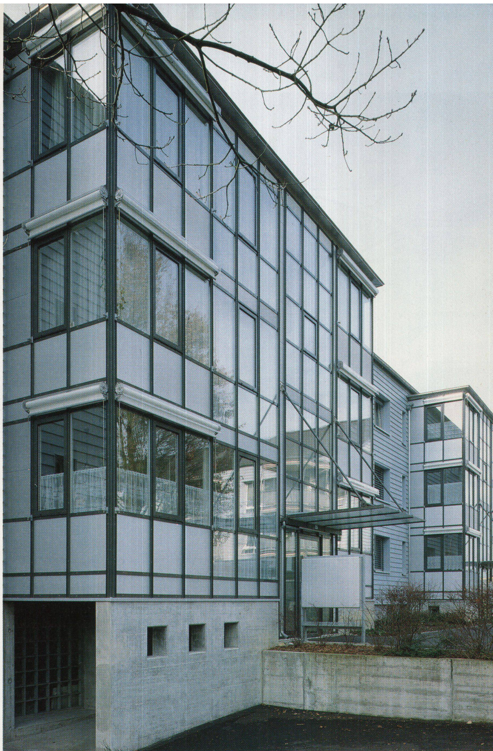
Die Erkeranbauten mit den neuen Hauseingängen, eine dem Haus vorgesetzte eigenständige Glas-Metallkonstruktion
