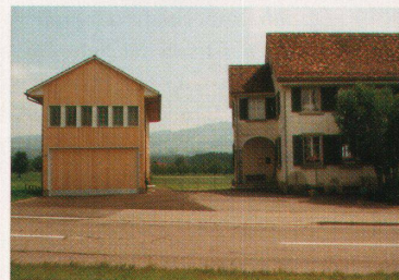
Renoviertes Schulensemble bei Hinwil
