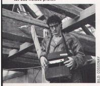
Sortierung von Bauholz nach Qualitätsklasse, wie sie bisher von Auge durchgeführt werden musste, lässt sich dank einer neuen Ultraschall-Messmethode fehlerfrei vornehmen. Die neue Methode hat die Probe am Exempel bestanden und wird in der Westschweiz bereits eingesetzt.
