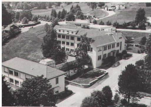
Die bestehenden Gebäude. Baugelände ist die Wiese links, aber auch der Streifen zwischen den Häusern und der Quartierstrasse.
