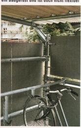
beim Baugerüst aus der Funktion ergibt, ist hier aufwendig inszeniert: Beim Gerüstebau sind alle Rohre als Halbfabrikate belassen, ein einziger Rohrtyp genügt. Die stumpf aufeinander stossenden Rohre des Veloständers dagegen bedingen eine genau definierte Rohrlänge. Einzelne Rohre sind gebogen oder an den Enden «gequetscht», und es werden drei verschiedene Rohrdurchmesser verwendet, die aus rein formalen Gründen auf sieben Arten miteinander verbunden sind.
