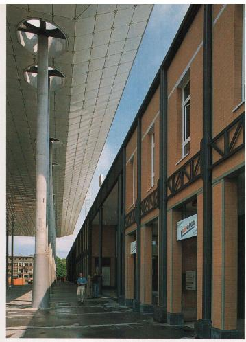
und Bedeutung zu verleihen. Clou und Blickfang der Anlage ist ein fussballfeldgrosses Tafeldach, das von 59 runden Betonstützen auf 16 Meter Höhe gehoben wird. Das Dach ist gleichermassen Zeichen und Funktion. Es schiebt sich, von weither erkennbar, in die Sichtachse der Wilhelmshöher Allee und schützt die Haltestellen mehrerer Tram- und Buslini-
