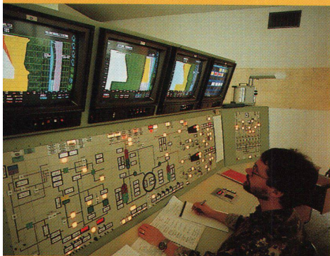
Bild links: Trainingssimulator des Kernkraftwerkes Beznau (Foto: Josef Stücker). Bild rechts: Golfsimulator (Foto: Christian Känzig)
