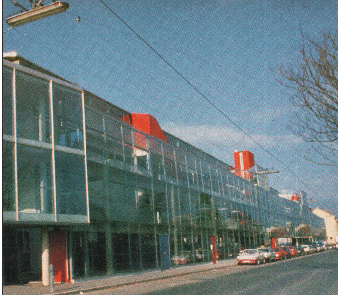
Ansicht von der stark befahrenen Strasse aus
