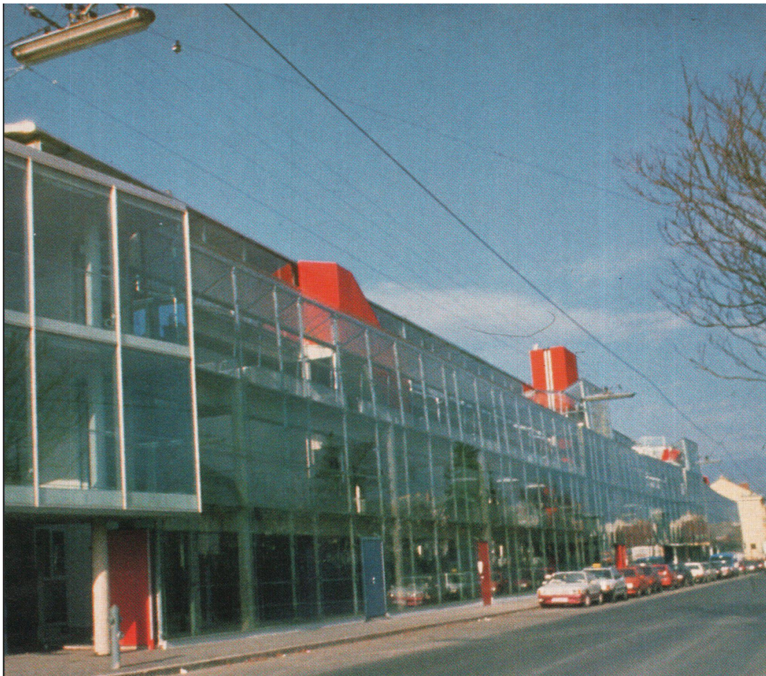
Ansicht von der stark befahrenen Strasse aus
