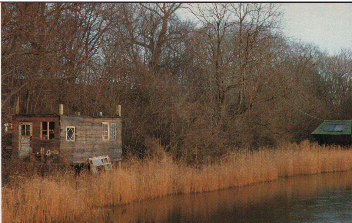
Die Häuser am See: Während die «fliegende Untertasse» (linkes Bild, Mitte) als erhaltenswert eingestuft wird, sollen die Hütten daneben abgerissen werden. Im «Christiania-Stil» (Bild rechts) auch die Toiletten.
