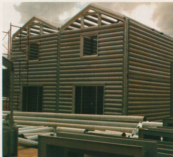
Aus Aluminiumbändern entstehen Rohre, aus diesen Häuser.
