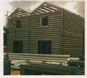
Aus Aluminiumbändern entstehen Rohre, aus diesen Häuser.
