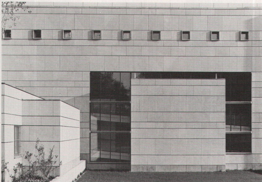
Die Nordfassade mit den durchs Fenster sichtbaren Rampen
