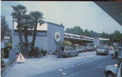
Das Motel: Coldrerio (N2)
