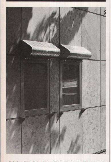
EINZELNE NATURSTEINPLATTE JEDE MUSCHELKALK IST ALLSEITIG UMGEBEN VON DEM SIE TRAGENDEN PROFILGERIPPE. DAS IM GLEICHEN EINGESETZTE SINNE FENSTERELE-SO MENT WIRD BESTANDTEIL FILIGRANEN FASSADENCHARAKTERS. ENTWORFEN UND AUSGEFÜHRT DURCH
