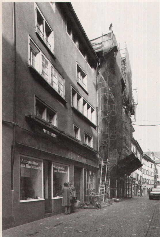
Das Haus am Rindermarkt 7 in der Zürcher Altstadt. Eine Stahlkonstruktion bewahrt es vor dem Zusammenbruch.
