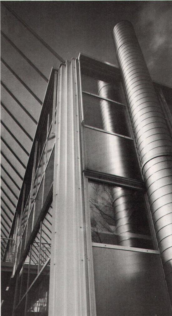
Vorgehängte Fassade aus einfachsten Profilformen wie Flachstahl und T-Stahl. Die Chromnickelstahl-Brüstung ist Bindeglied in den spiegelnden Glasflächen. Konstruiert und ausgeführt durch die Fassadenbauer aus
