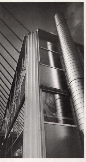
Vorgehängte Fassade aus einfachsten Profilformen wie Flachstahl und T-Stahl. Die Chromnickelstahl-Brüstung ist Bindeglied in den spiegelnden Glasflächen. Konstruiert und ausgeführt durch die Fassadenbauer aus 3422 Kirchberg.
