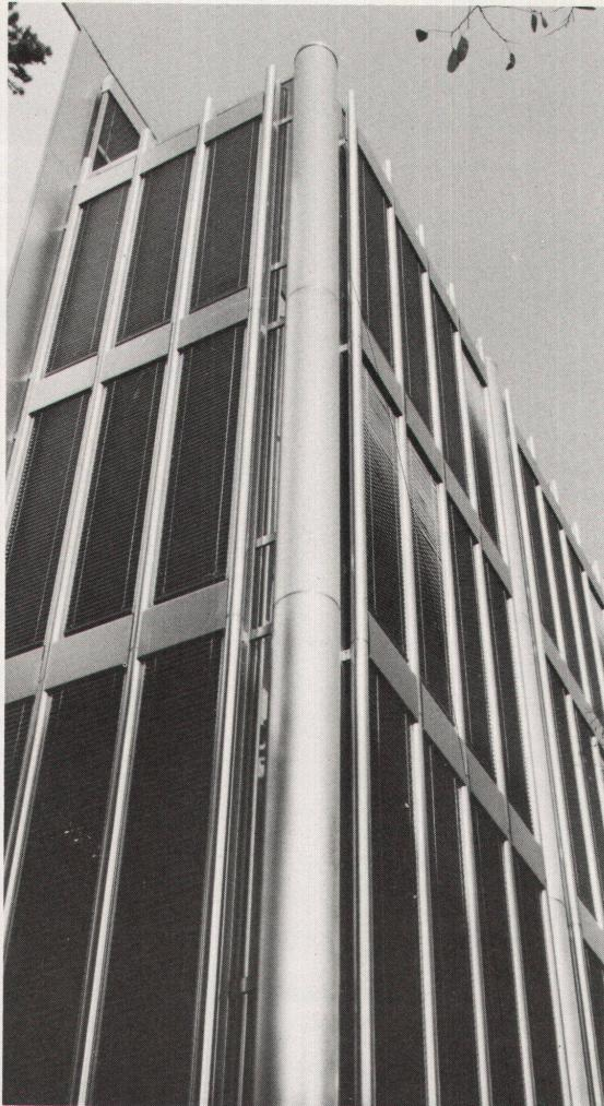
Chromnickelstahl-Fassade mit zurückgesetzten Verglasungsebenen. Die tragenden Rundstützen sind mit gerundeten Inox-Platten ummantelt. Das Thema findet seine Fortsetzung in verfeinerten, vorgesetzten Rohrprofilen als Träger des Sonnenschutzes. Konstruiert und ausgeführt durch die Fassadenbauer aus
