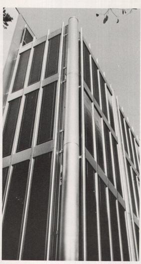
Chromnickelstahl-Fassade mit zurückgesetzten Verglasungsebenen. Die tragenden Rundstützen sind mit gerundeten Inox-Platten ummantelt. Das Thema findet seine Fortsetzung in verfeinerten, vorgesetzten Rohrprofilen als Träger des Sonnenschutzes. Konstruiert und ausgeführt durch die Fassadenbauer aus 3422 Kirchberg.
