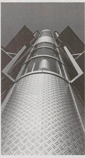
Isolierte Stahlfassade mit vorgehängter Beschattungsanlage und kompromisslos ausgebildeter Eckzone sind Ausdruck der Reduktion auf Elementares. Konstruiert und ausgeführt durch die Fassadenbauer aus 3422 Kirchberg BE. Telefon 034/45 11 33.
