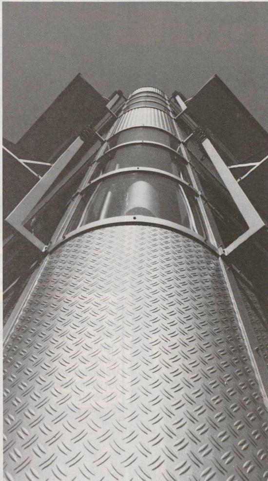
Isolierte Stahlfassade mit vorgehängter Beschattungsanlage und kompromisslos ausgebildeter Eckzone sind Ausdruck der Reduktion auf Elementares. Konstruiert und ausgeführt durch die Fassadenbauer aus 3422 Kirchberg BE.
