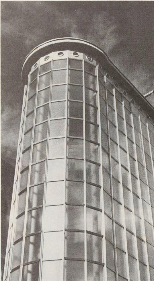
Die filigran aufgebaute Treppenhaus-Fassade in Chromnickelstahl mit leicht transparenter Verglasung zeichnet sich aus durch grosse Zurückhaltung zugunsten beidseitig anstossender Gebäudekomplexe aus den dreissiger Jahren. Konstruiert und ausgeführt durch die Fassadenbauer aus 3422 Kirchberg/BE. Telefon 034/451133.
