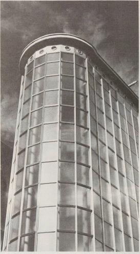
Die filigran aufgebaute Treppenhaus-Fassade in Chromnickelstahl mit transparenter Verglasung leicht zeichnet sich aus durch grosse Zurückhaltung zugunsten beidseitig anstossender Gebäudekomplexe aus den dreissiger Jahren. Konstruiert und ausgeführt durch die Fassadenbauer 3422 Kirchberg/BE. aus Telefon 034/45 11 33.
