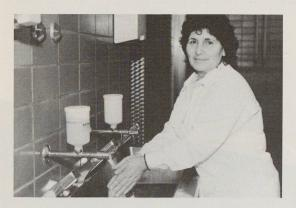
die einwandfreie Hygiene beginnen. Die Geberit AG bietet dafür berührungslose Handwaschanlagen an: Die Waschtische sind mit elektronischen Wandbatterien ausgerüstet. Durch die Infrarotsensorik wird der Wasserstrahl berührungslos
