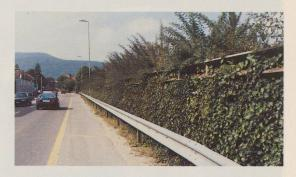
dividuell bepflanzt. Die Merkmale dieses Lärm- und Abgasschutzes sind: lange Lebensdauer, hohe Schallabsorption, Staub- und Geruchfilter, natürlicher Lebensraum für Tiere und Pflanzen und schönes Aussehen. Die Montage ist einPflanzen und Erde als Schutz vor Lärm und Filter gegen Luftverschmutzung
