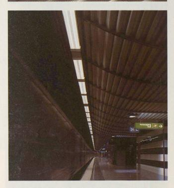
Bartenbach-Beleuchtung im zweiten Untergeschoss der Baustelle Zürcher Hauptbahnhof: In die aluverkleidete Decke sind Halogenleuchten eingelassen, deren Licht von Spiegeln auf die reflektierende Decke und von da auf den Boden gestreut wird.
