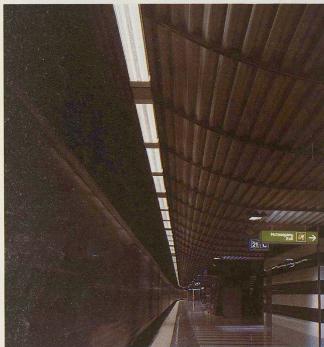
Bartenbach-Beleuchtung im zweiten Untergeschoss der Baustelle Zürcher Hauptbahnhof: In die aluverkleidete Decke sind Halogenleuchten eingelassen, deren Licht von Spiegeln auf die reflektierende Decke und von da auf den Boden gestreut wird.
