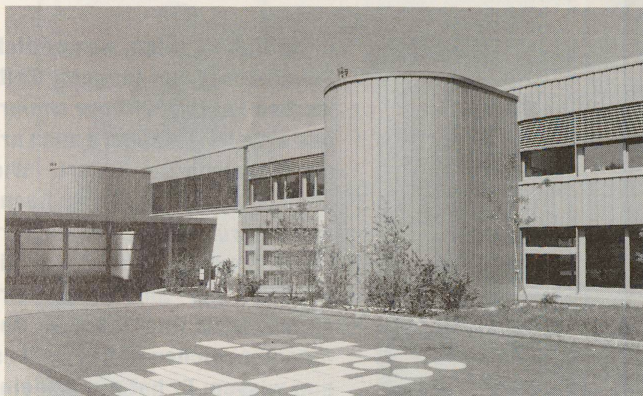
Nach der Sanierung: tiefrotes Aluminium verhüllt die ursprünglichen Beton- und Durisolfassaden. Neu auch das flache Giebeldach (im Bild nicht sichtbar) und die veränderte Eingangssituation gegenüber der vorherigen seitlichen, offenen Eingangshalle.
