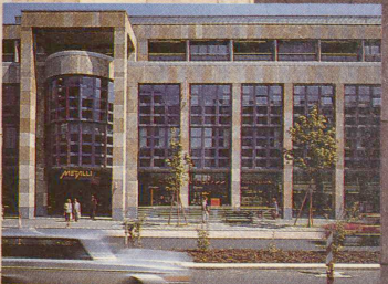
Rückfassade mit Anlieferung. Die Treppentürme sind Wehrtürme geworden. Gegen welchen Feind?
