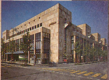
Ausschnitt aus der Fassade gegen die kommende vierte Etappe (groses Bild). Die Probleme des Steinschnitts sind bewältigt.
