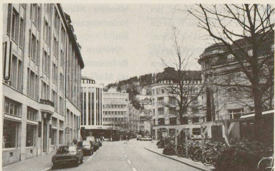
Vorher – Nachher: Das «Helvetia»-Gebäude wurde 1977 abgebrochen und durch einen Neubau ersetzt.
