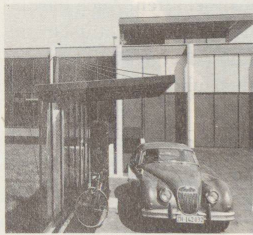
Fabrik Walt, Fällanden, Galvanische Anstalt; Architekt: Otto Kolb, Architekt AIA
