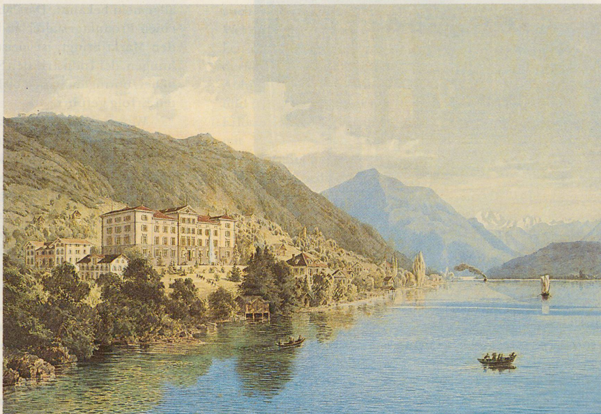
Die «alte Chruzhütte» – so Kantonsbaumeister Albert Glutz – war einst ein stolzes Schulhaus: 1869 wurde es als Handelsinstitut Neu-Frauenstein erbaut und wechselte später mehrmals Namen und Inhalt, bis es zum Lagerhaus degradiert wurde.
