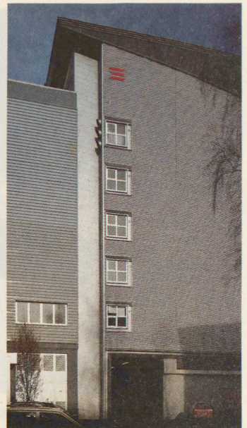
Stirn-, Seitenfassade und der Anschluss des Neubaus an den Altbau der Rauchgasreinigungsanlage in Salzburg. Alle Öffnungen sind an die Gebäude-ränder gedrängt. Die grossen Blechflächen dazwischen vergrössern ihre optischen Ausmasse und verfremden das Material: Edelfläche mit Schmuckrändern. Die Kerbe zwischen Alt- und Neubau wird mit einem andern Material und mit gröberer Struktur betont. Auch der Sockel wird als Randfeld behandelt. Die ausschwingende Dachlinie dramatisiert die Krümmung des Dachs. Im Wechsel des Lichts, namentlich bei Sonnenschein, verändern die Bleche ihre Aussage. Das Billige wird edel. Glänzend, glitzernd, «Wände von Edelstein». Alles ist noch materialecht wie einst, und doch verändert sich die Aussage.
