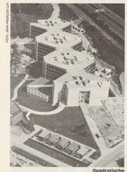
Blöcke, auf einer Diagonale angeordnet, mit Hörsälen, die in ebenfalls quadratischen Stahlkonstruktionen aussen angehängt sind.
