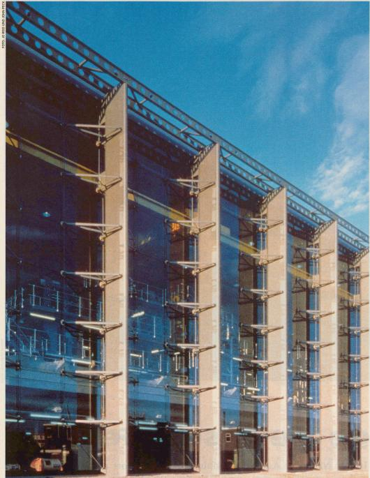
Die Nordfassade der neuen Druckerei der «Financial Times» besteht aus einer Glaswand. So wird die Zeitungsherstellung von aussen sichtbar.
