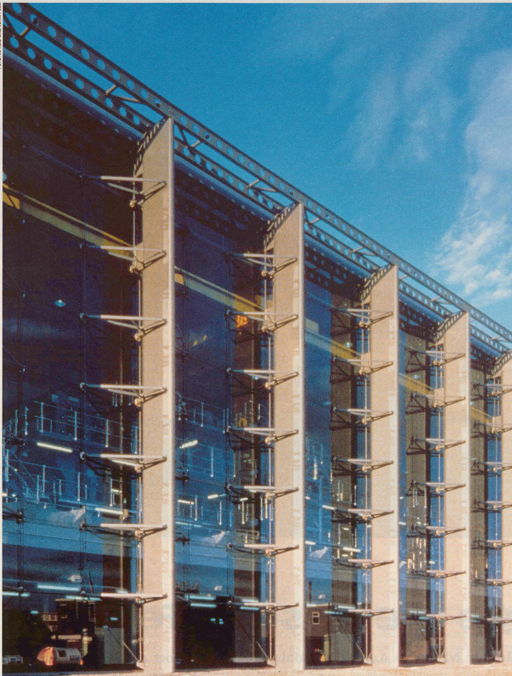
Die Nordfassade der neuen Druckerei der «Financial Times» besteht aus einer Glaswand. So wird die Zeitungsherstellung von aussen sichtbar.
