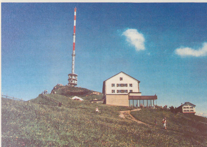
Der bestehende Antennenturm auf Rigi-Kulm (oben) ist 50 Meter hoch. Der Nachfolger soll nicht nur mehr als doppelt so hoch werden, sondern auch mit riesigen Parabolspiegeln bestückt sein (unten).
