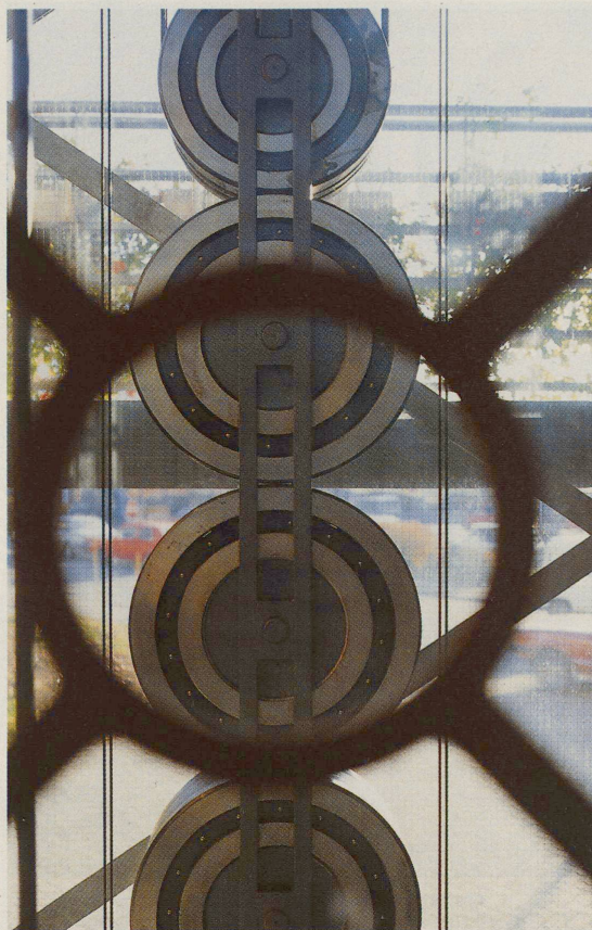
Kugellager als Gegengewicht am Lift in der Kugellager-Handelsfirma, gesehen durch das runde Fenster in der Kabinentüre: Der Architekt hat signethaft jene Form aufgenommen, die den Betrieb in seinem Bau prägt.
